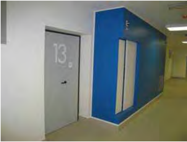
Vano esterno per la manutenzione tecnica delle stanze di degenza e terapia subintensiva
