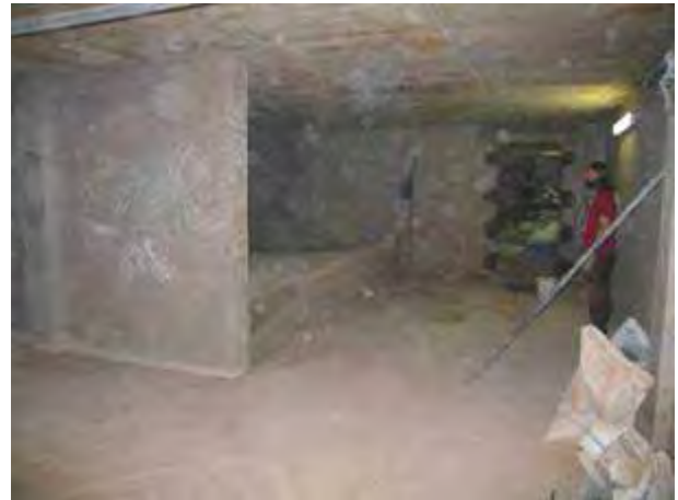
Il labirinto dell'aria nel seminterrato: la seconda e la terza barriera
