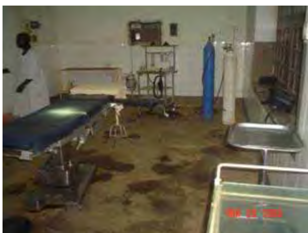
La sala operatoria dell'ospedale di Al Fashir prima della ristrutturazione di Emergency
