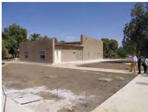
Edificio mensa e cucina
