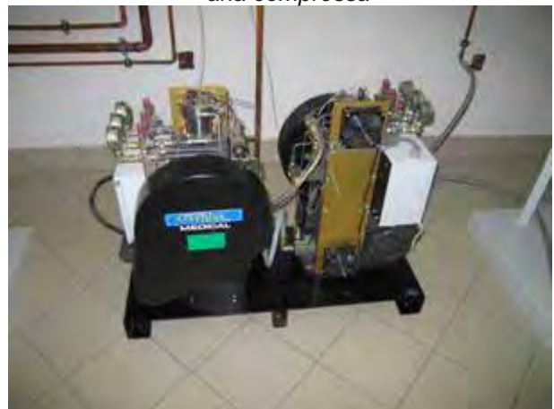
Compressore per la produzione ossigeno
