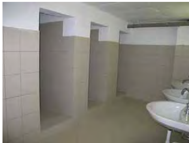
Spogliatoio del personale nel seminterrato
