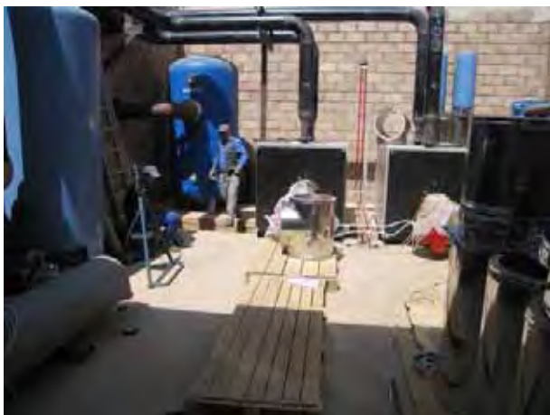
Interno dell'edificio tecnico
