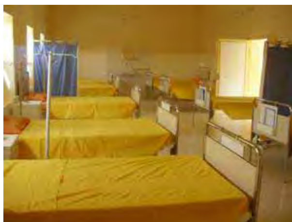
Corsia dell'ospedale di Al Fashir dopo la ristrutturazione di Emergency
