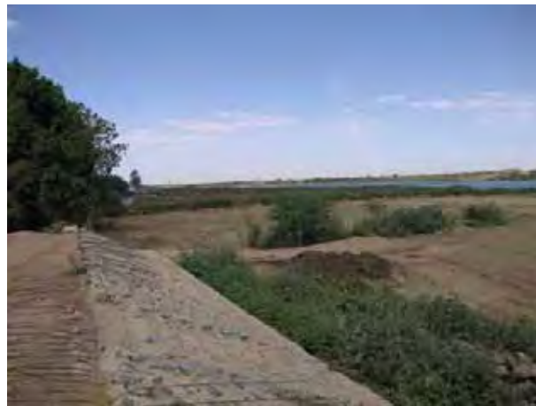
Terrazza sul Nilo Azzurro: barriera di contenimento inondazioni
