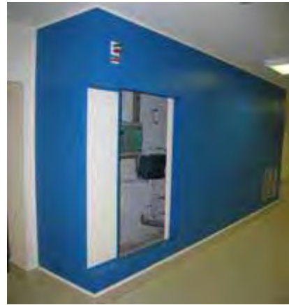
Dettaglio sul vano
