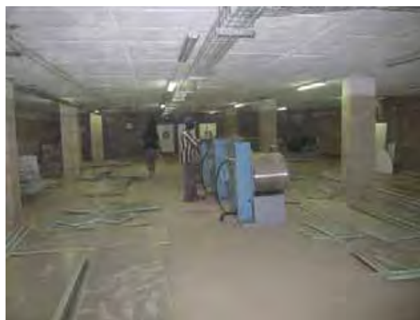
Lavanderia nel seminterrato
