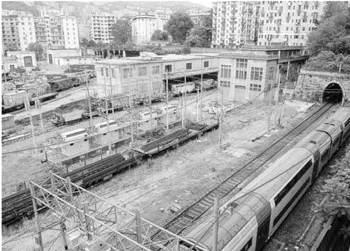
Il centro di manutenzione di Terralba, nei pressi della stazione di Genova Brignole
